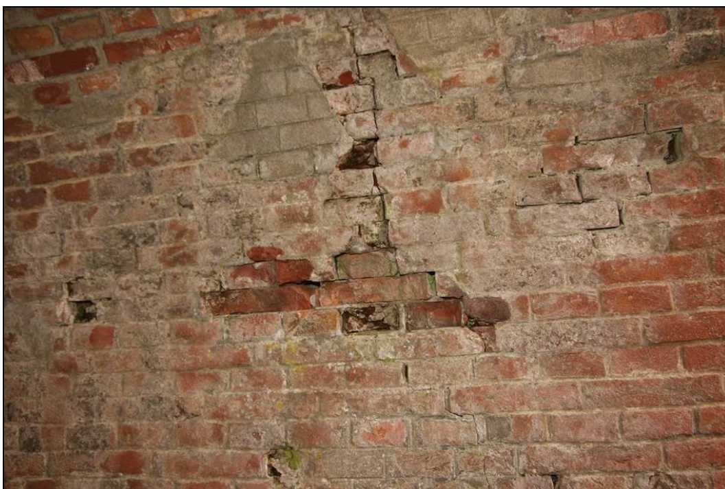
- Obr. č. 6 – Detailnější pohled na průběžnou trhlinu v pravé části opěry Moravské Budějovice
