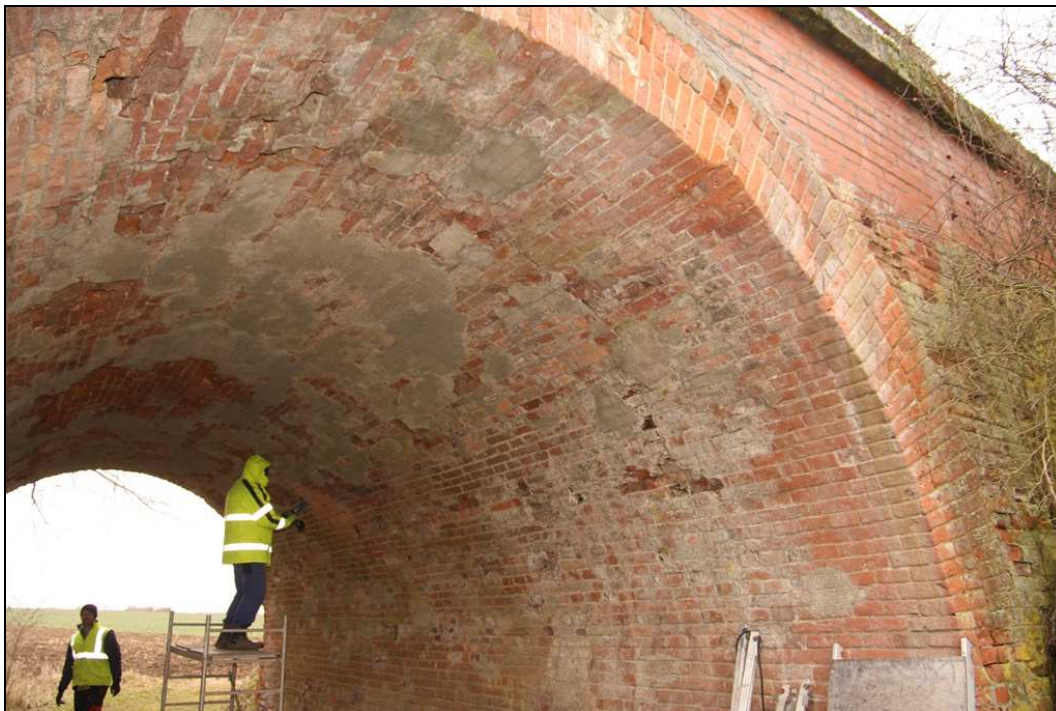
- Obr. č. 5 – Pohled na pravou část opěry Moravské Budějovice, viditelná trhlina cca 1,2m od čela probíhající od soklu až do vrcholu klenby
