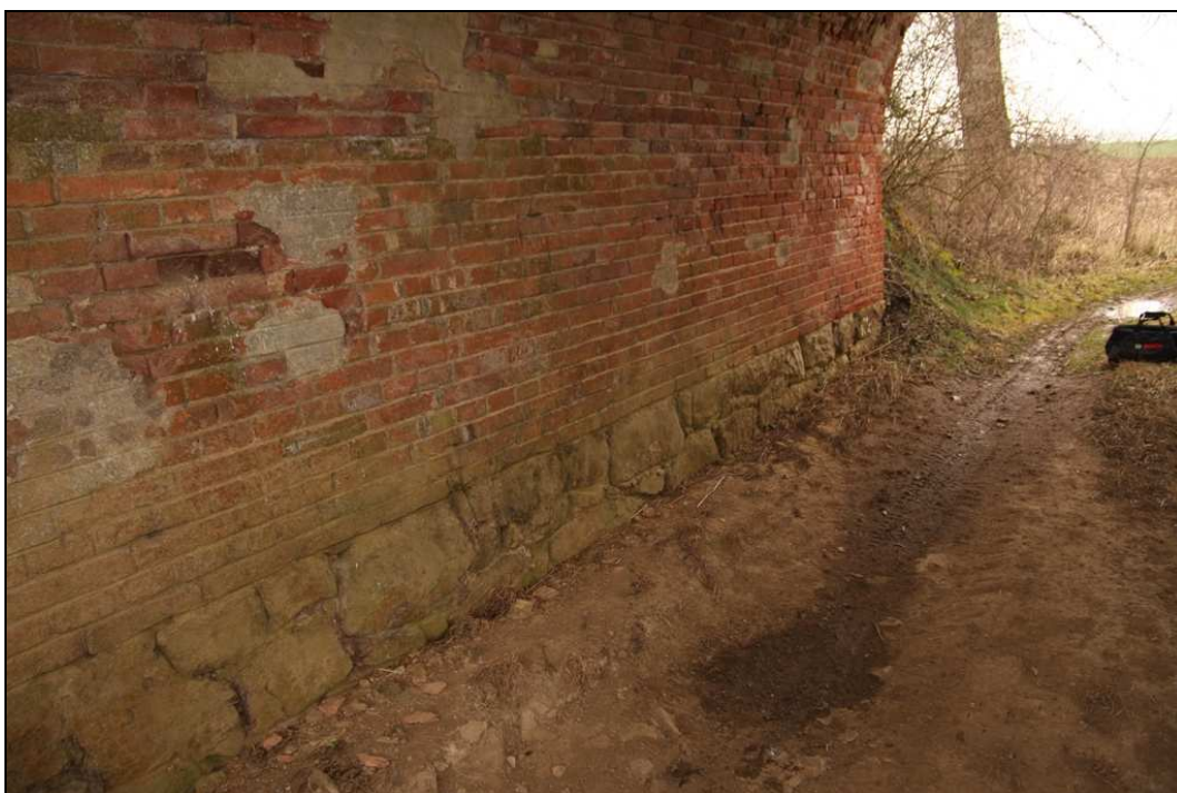
- Obr. č. 8 – pohled na znojemskou opěru na značně degradované spáry soklu i ojedinělou hloubkovou degradaci cihelného zdiva SS
